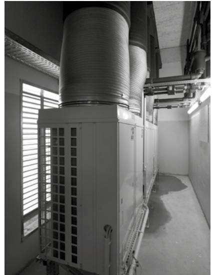
\* Für die Frischluftzufuhr muss ein Gitter vorgesehen werden, und Kanäle müssen an dem/den Conveni-pack-Gerät(en) montiert werden.
